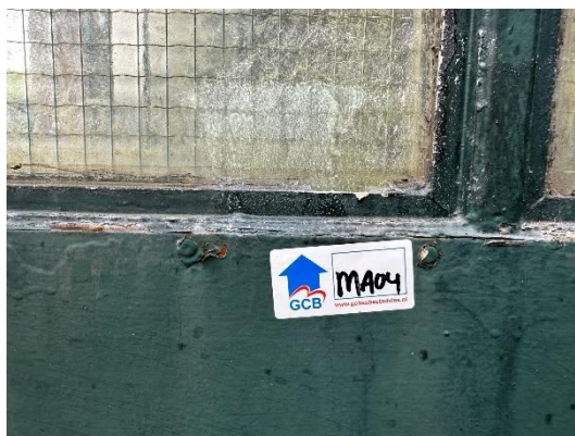
Monsternamelocatie MA04 (asbest niet aantoonbaar)
