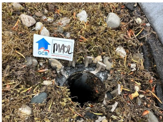
Monsternamelocatie MA02 (asbest niet aantoonbaar)
