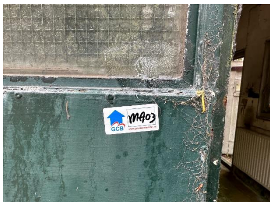
Monsternamelocatie MA03 (asbest niet aantoonbaar)
