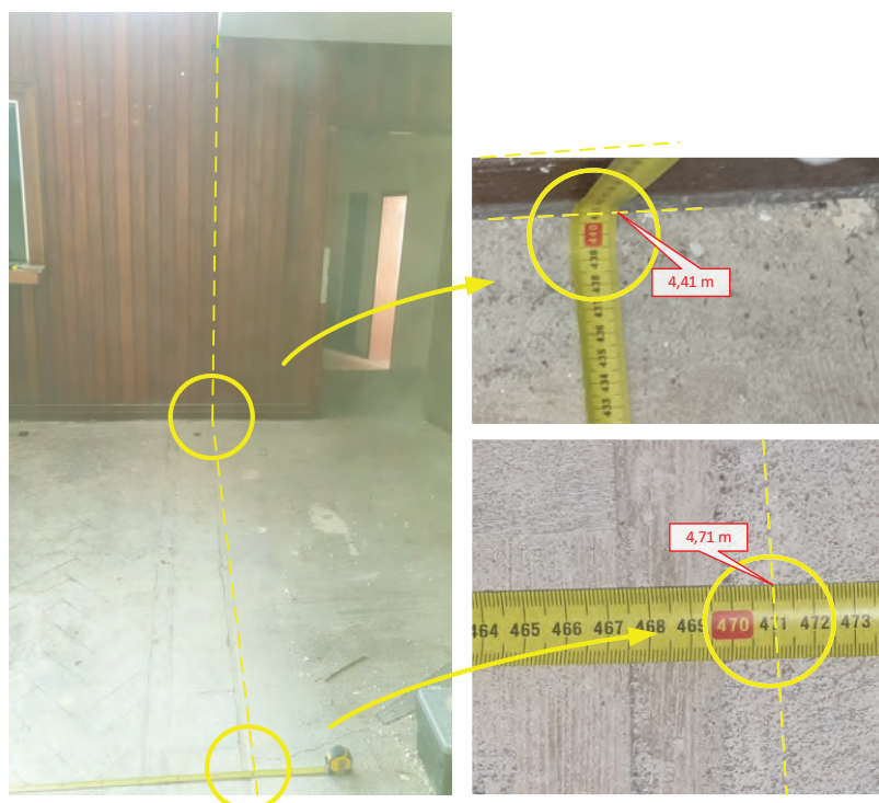
Figuur 4 Ingemeten dagmaten te renoveren dakvlak
