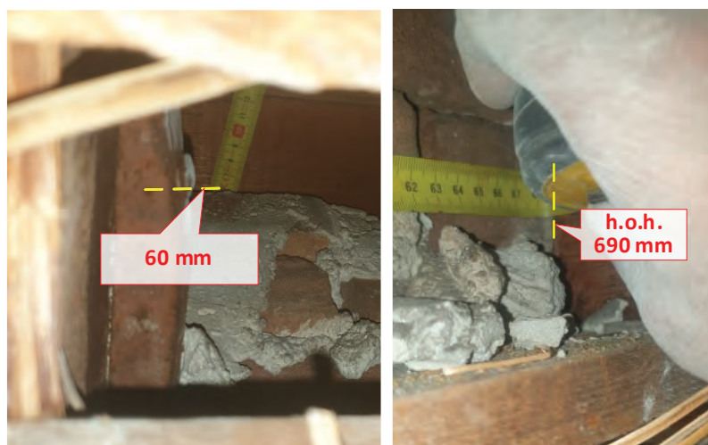
Figuur 13 Resp. vrije ruimte naast dakbalk voorbij oplegging (links), h.o.h. maat dakbalken (midden) en balkhoogte (rechts)
