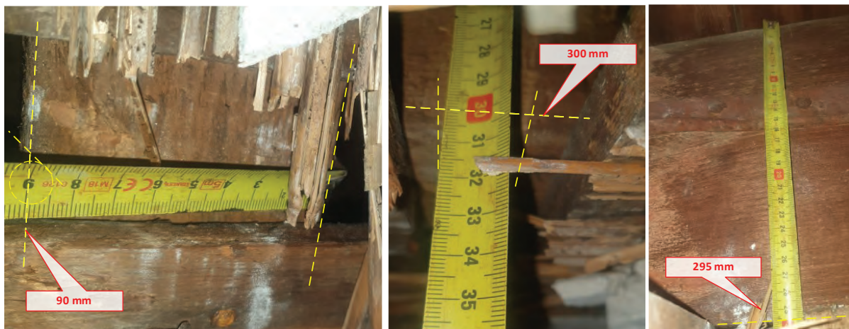
Figuur 12 Resp. balkbreedte (links), balkhoogten naast elkaar gelegen balken (midden en rechts)
