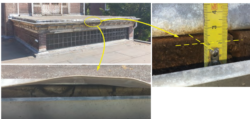
Figuur 14 Aanzicht dak met uitbreidingen 1974 rond en dakbeschot
